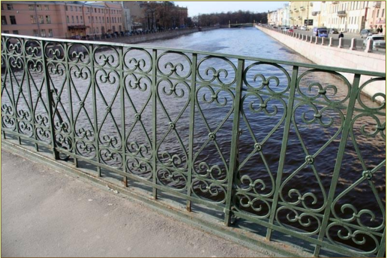
Ограда моста Белинского
