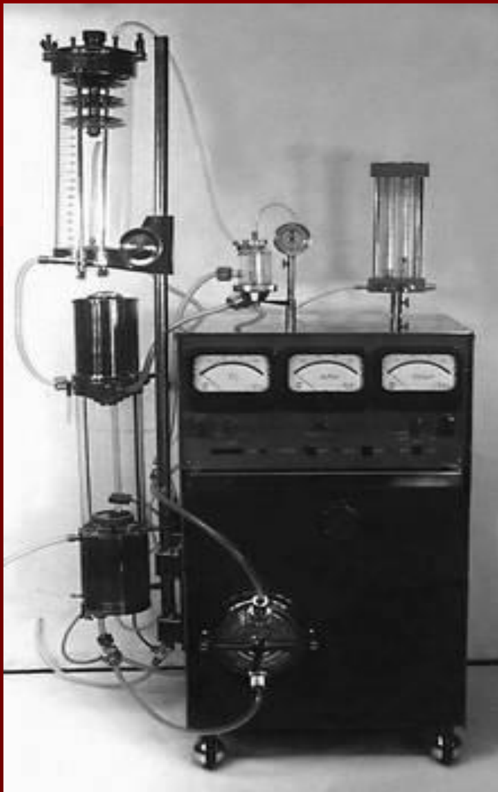
Аппарат искусственного кровообращения АИК-5 кардиохирургического назначения.
