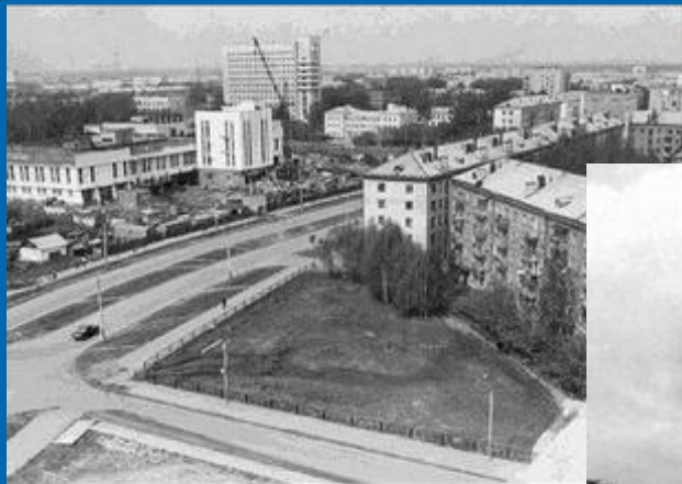
Строительство кардиоцентра (вид с крыши)
