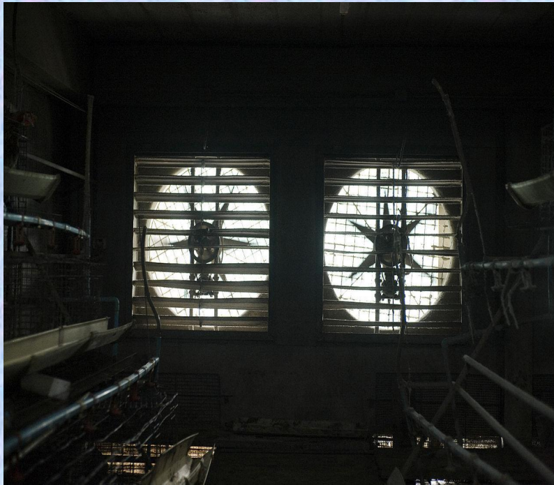
Принудительная вентиляция на птицефабрике.
