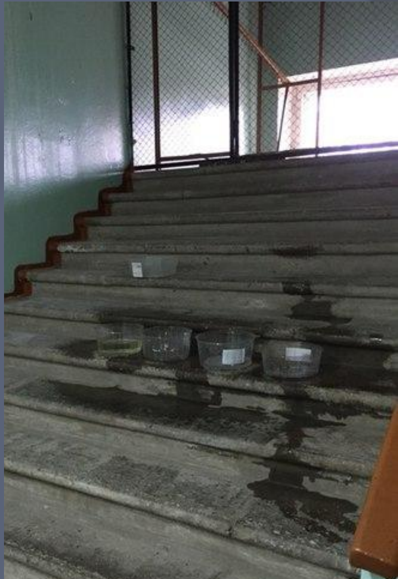
Корпус «В», 4 этаж
