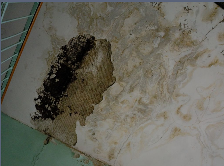
Корпус «В», 4 этаж
