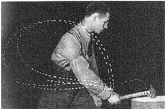
Циклограмма рубки зубилом
