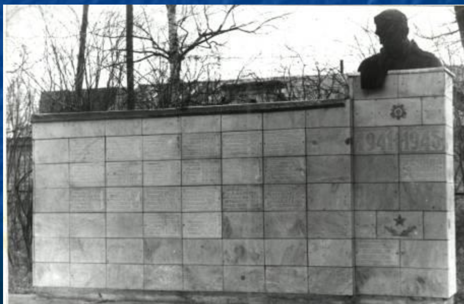
(сфотографирован во время сооружения)
