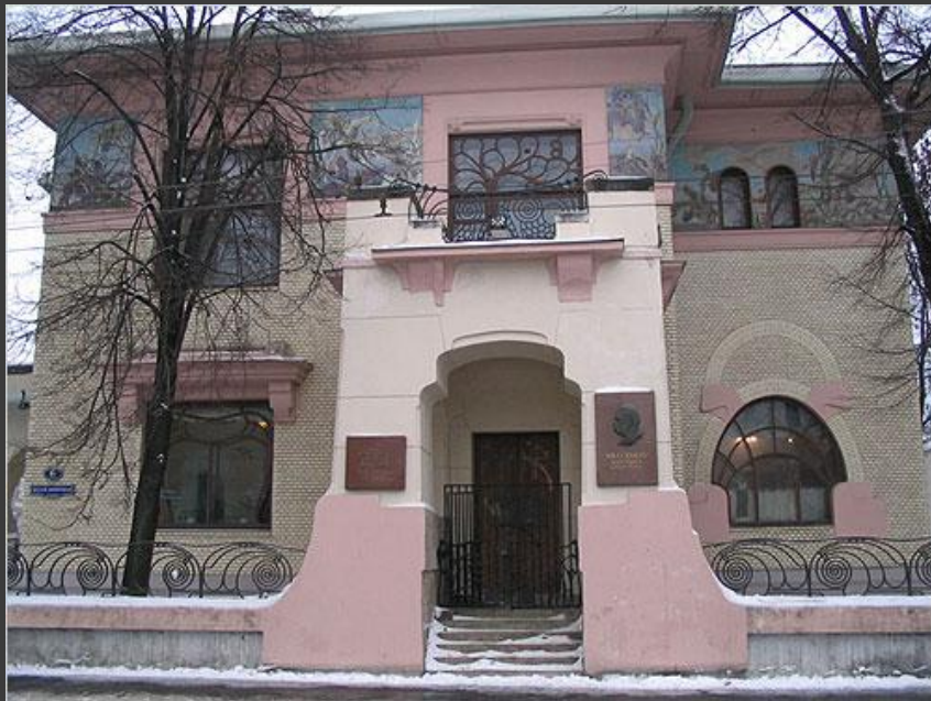
Особняк С.П. Рябушинского. 1902 – 1906 гг.
