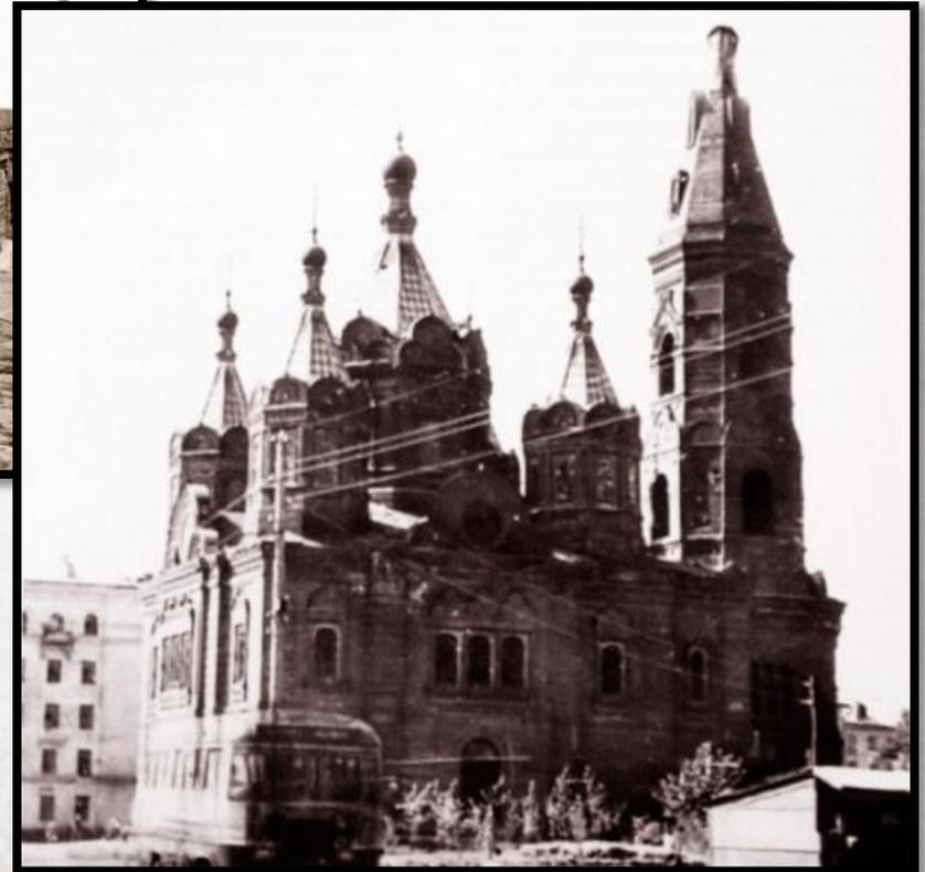
При сооружении храма использовались многие технические новшества того времени: железобетонные перекрытия, гидrolитный пол, облицовочная плитка, цемент, система парового отопления... Основание храма сложено из крупных блоков известняка; стены, шатры и декоративный узор — из кирпича
