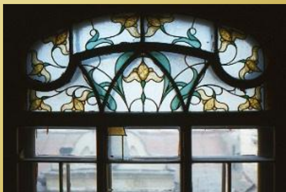
Парадный подъезд доходного дома
