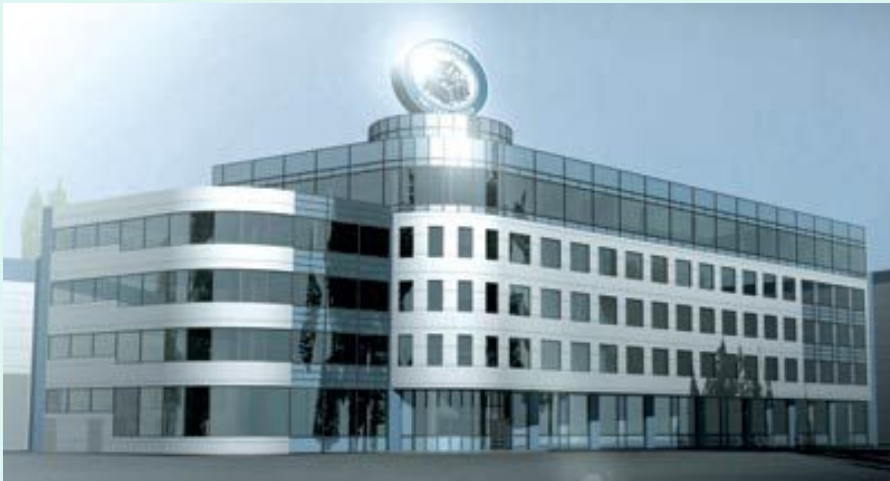
Административно-производственное здание компании «Чистая вода» (Новосибирск)
