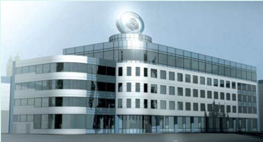
Административно-производственное здание компании «Чистая вода» (Новосибирск)
