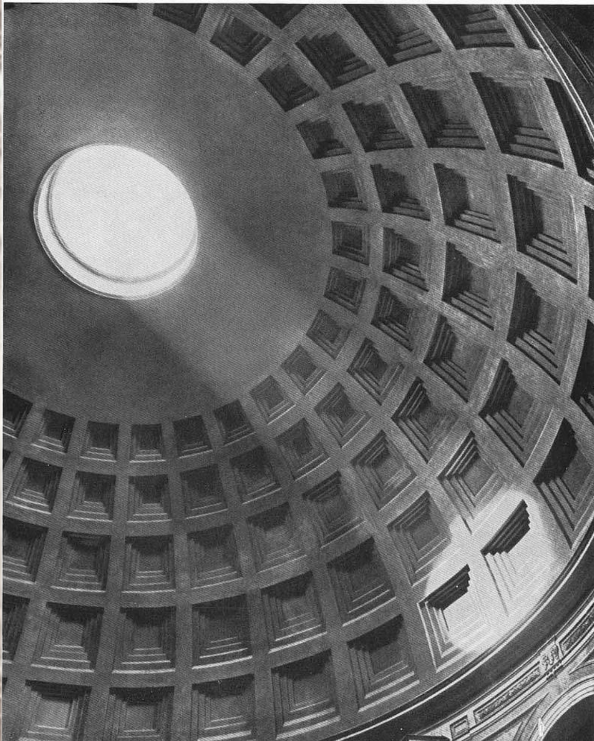
Пантеон. Около 125 г. Внутренний вид купола (кассетированный потолок). Рим
