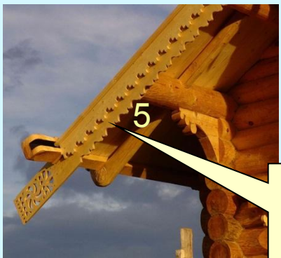
Верхняя треугольная часть дома
