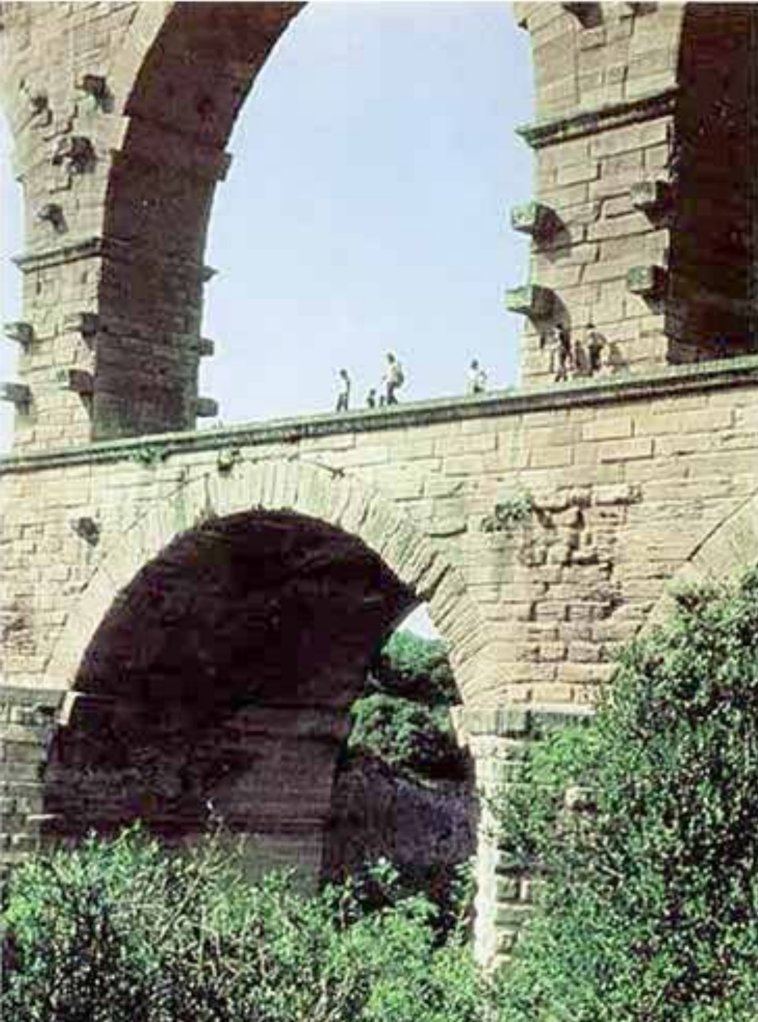
Гарский мост (акведук в Ниме). Деталь.
