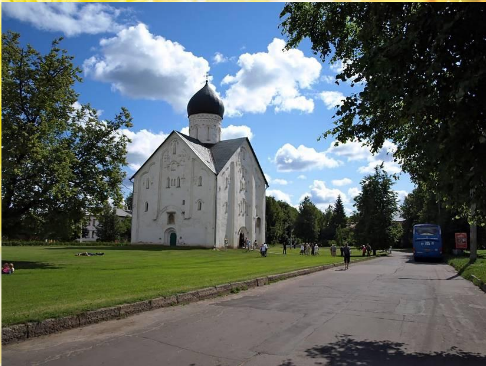
Церковь Спаса-Преображения на Ильине улице
