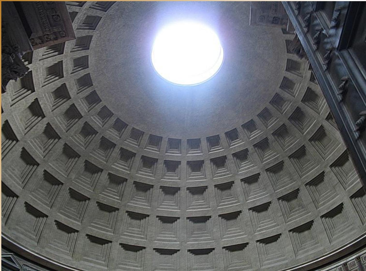
**Высота от пола до отверстия в своде в точности соответствует диаметру основания купола; таким образом, храм удивительно пропорционален.**
