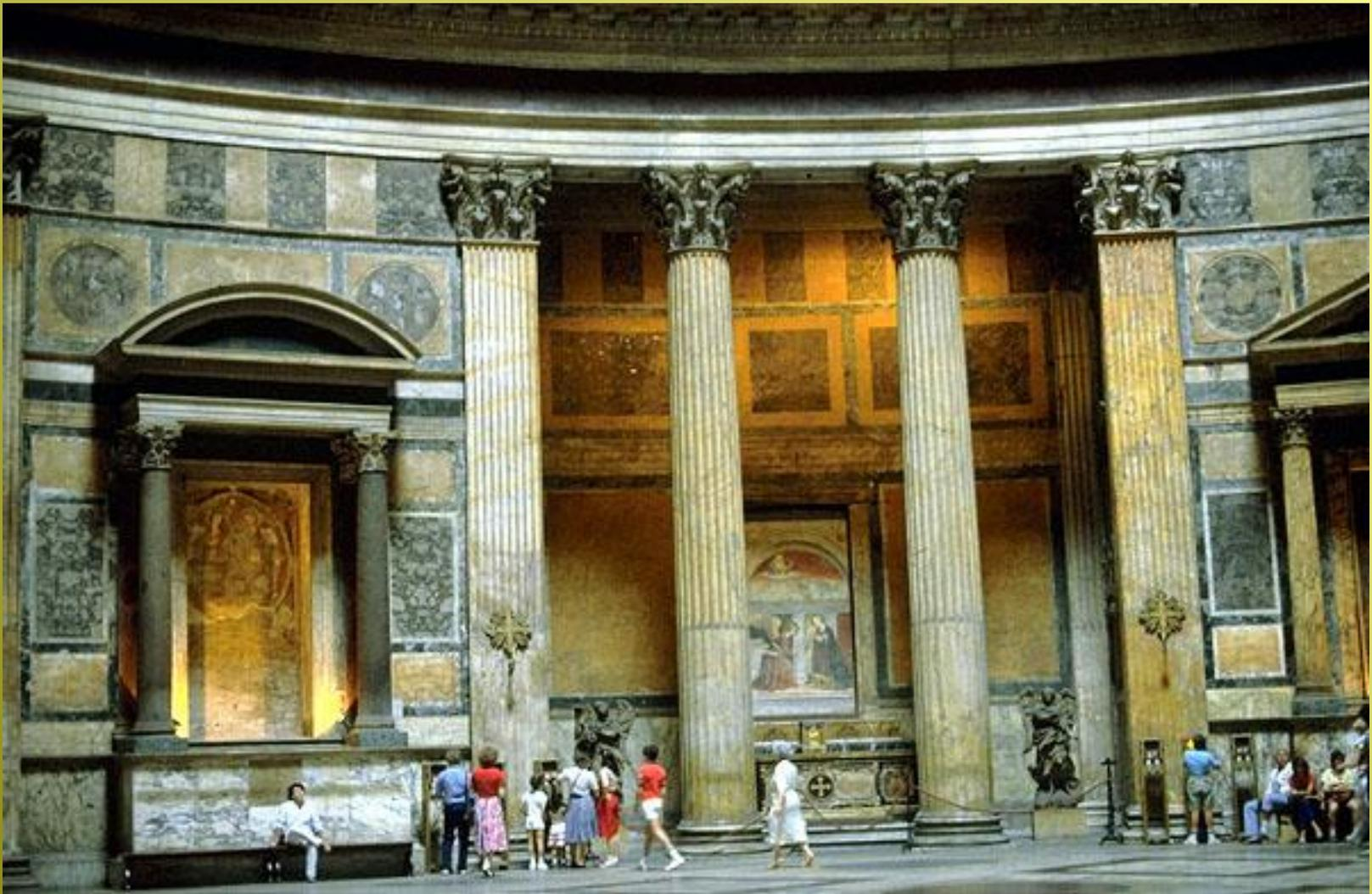
**Между ними архитектор смело разместил прикрытие колоннами ниши — углубления в массивной бетонной стене; они не сквозные, но обеспечивают иллюзию открытого пространства позади опор, создавая впечатление, что стены не столь толсты, а купол гораздо легче, нежели в действительности.**
