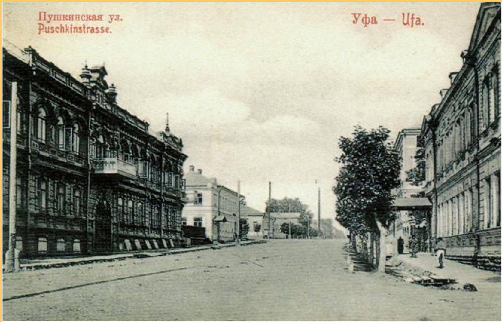
Ул. Пушкинская (Пушкина)
