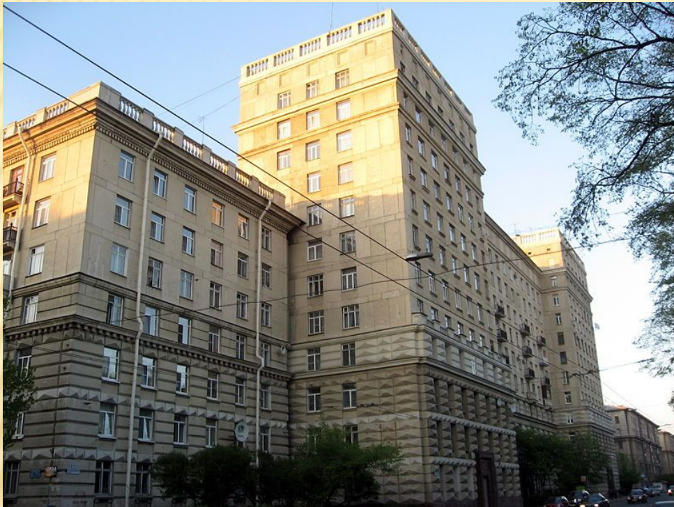
Первый 12-этажный дом на ул. Кузнецовской, 44. Арх. Журавлев (в соавторстве с арх. А.Д. Кацем и инженером Н.И. Дюбовым)
