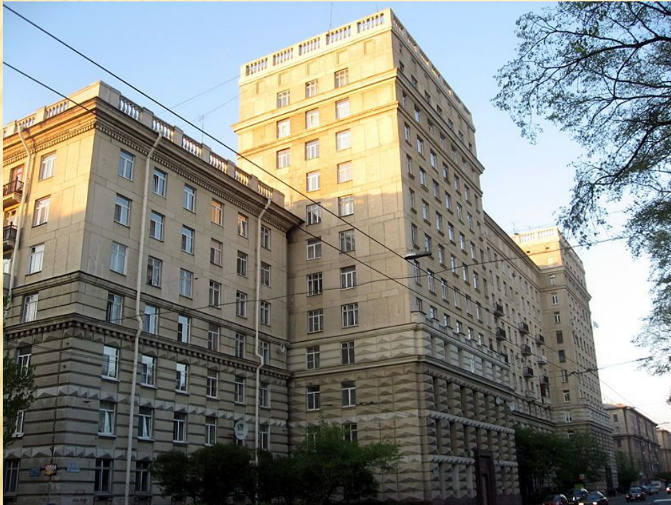
Первый 12-этажный дом на ул. Кузнецовской, 44. Арх. Журавлев (в соавторстве с арх. А.Д. Кацем и инженером Н.И. Дюбовым)
