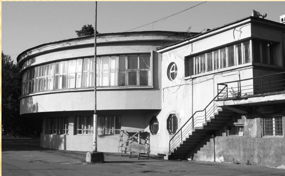
Одно из сооружений Спорткомплекса «Динамо» в Ленинграде, архитектор О.Л. Лялин (1925-1934)
