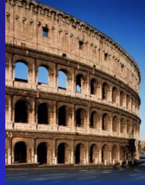
Использование круглого ЦИЛИНДРИЧЕСКОГО (БОЧАРНОГО) свода, опирающегося боковыми сторонами на несущие стены, и пересечение этих цилиндров, позволило создать совершенно новый тип перекрытия - СВОДЧАТЫЙ (КРЕСТОВЫЙ). Римляне обращаются к греческой ордерной системе, но по-новому понимают ее значение. В Риме ордер имеет декоративную роль, так как опорные функции выполняет стена.
