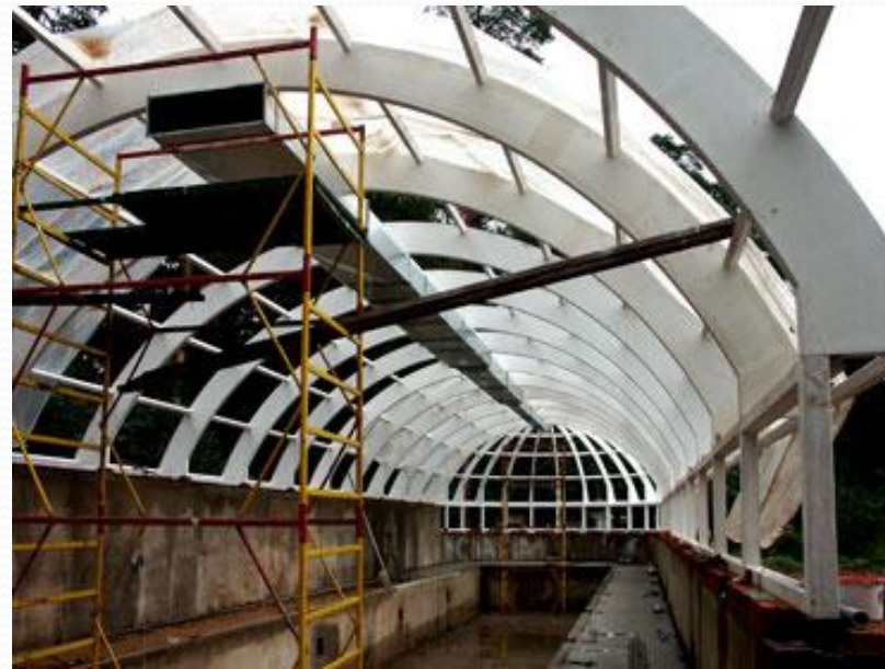
Каркас остекления бассейна. Арх. Александр Чернобай
