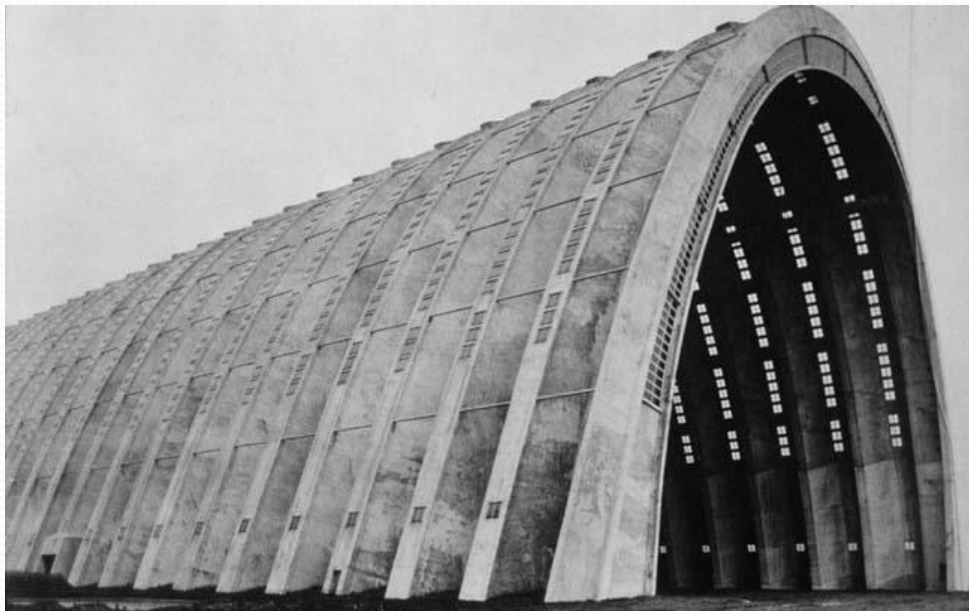
Ангар для воздушных судов. Орли(Франция). Построен в 1924г. Арх. Эжен Фрейсине.
