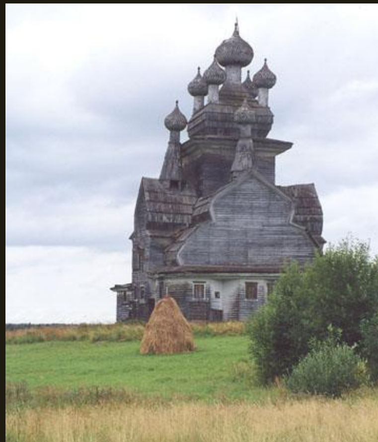
Церковь из с. Подпорожье Онежского р-на Архангельской обл.
