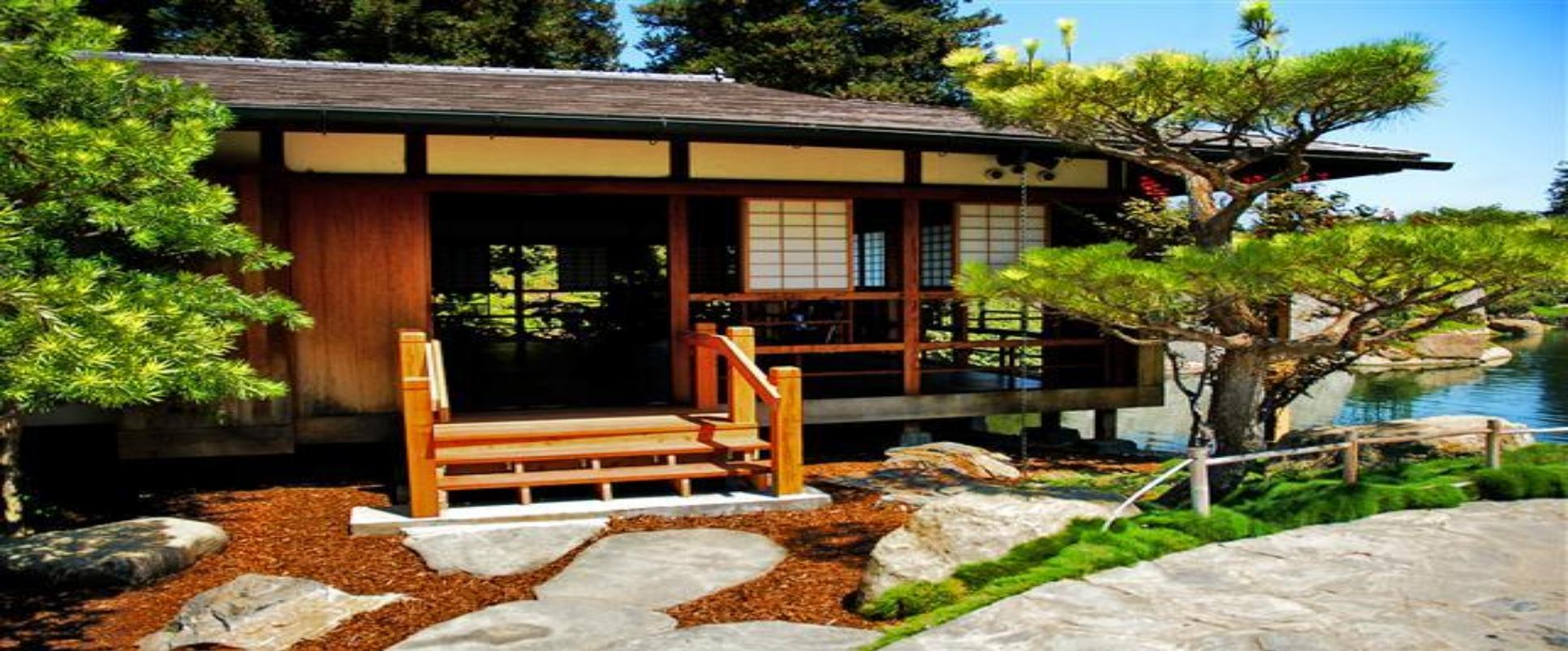
Конструкция традиционного японского дома сложилась к 17-18 в. Он представляет собой деревянный каркас с тремя подвижными стенами и одной неподвижной. Стены не несут функций опоры, поэтому они могут раздвигаться или даже сниматься, служить одновременно и окном. В тёплый сезон стены представляли собой решётчатую конструкцию, оклеенную полупрозрачной бумагой, пропускавшей свет, а в холодное и дождливое время их прикрывали или заменяли деревянными панелями
