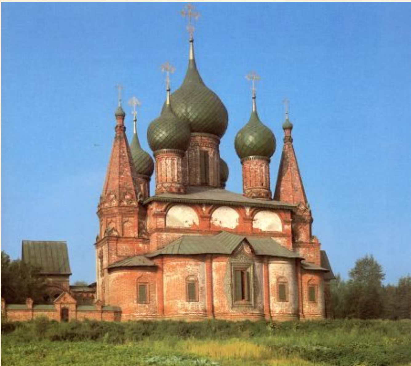
Ярославль. Церковь Иоанна Златоуста
