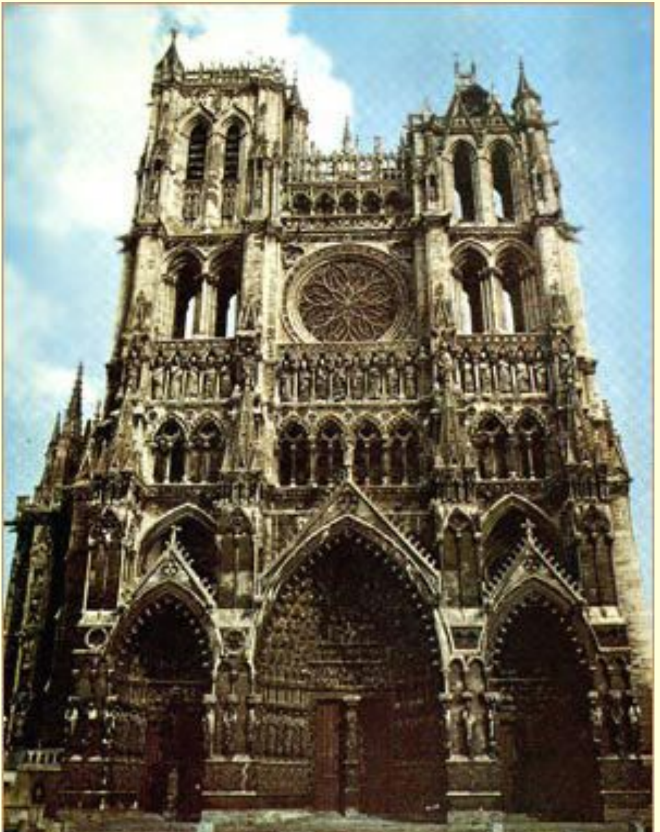
Собор в Амьене. Западный фасад. XII в.
