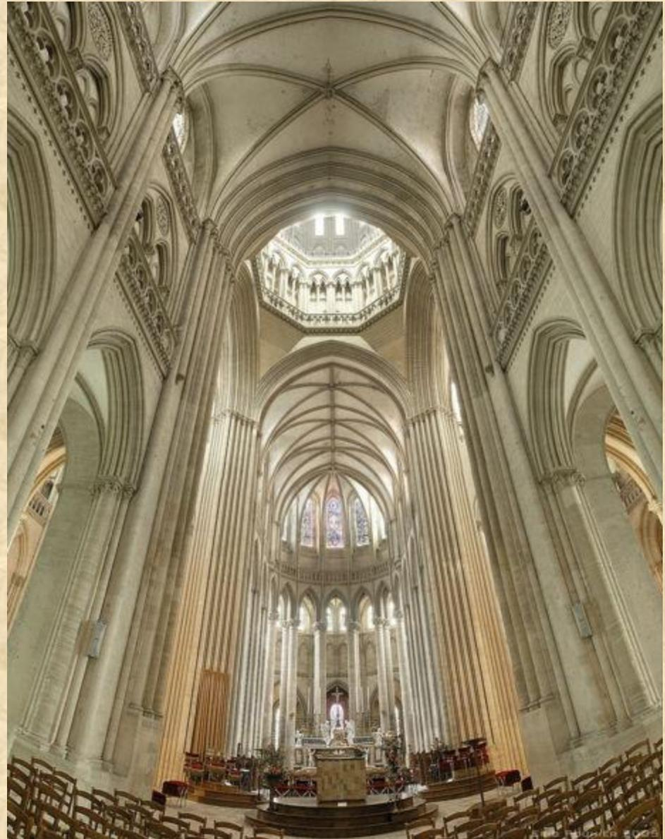
В конструкцию свода включалась система несущих арок из особого прочного камня, называемых **нервюрами**.
