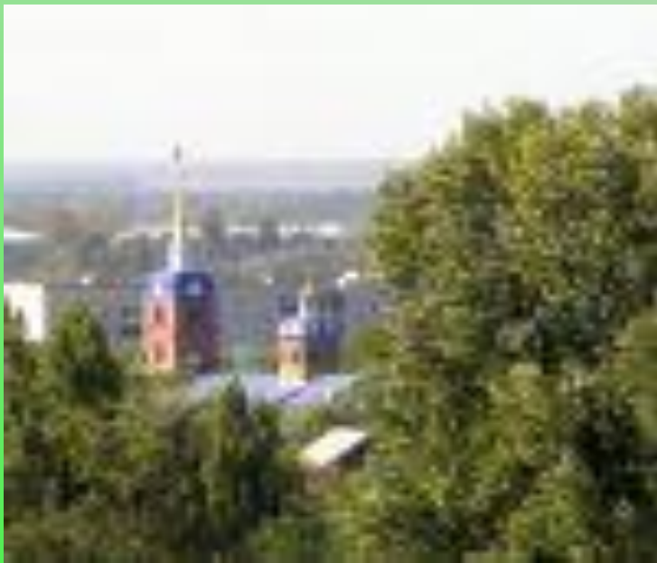
Идет строительство храма
