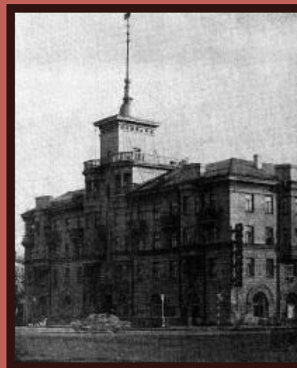
Жилой дом «под шпилем» на Октябрьской площади.1956
