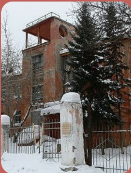
Здание в стиле конструктивизма, пр. Комсомольский, 115
