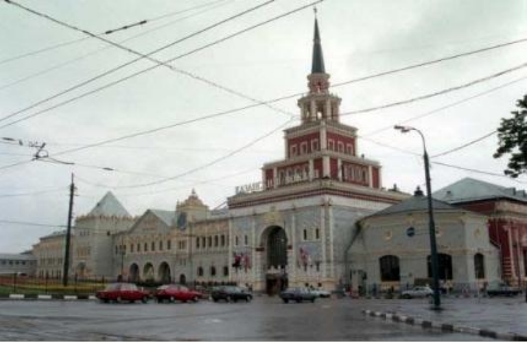
Щусев А.В. Здание Казанского вокзала в Москве
