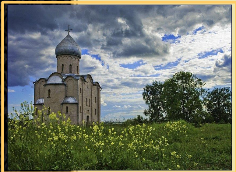
Церковь Спаса на Нередице
