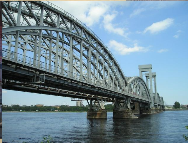
Финляндский железнодорожный мост
