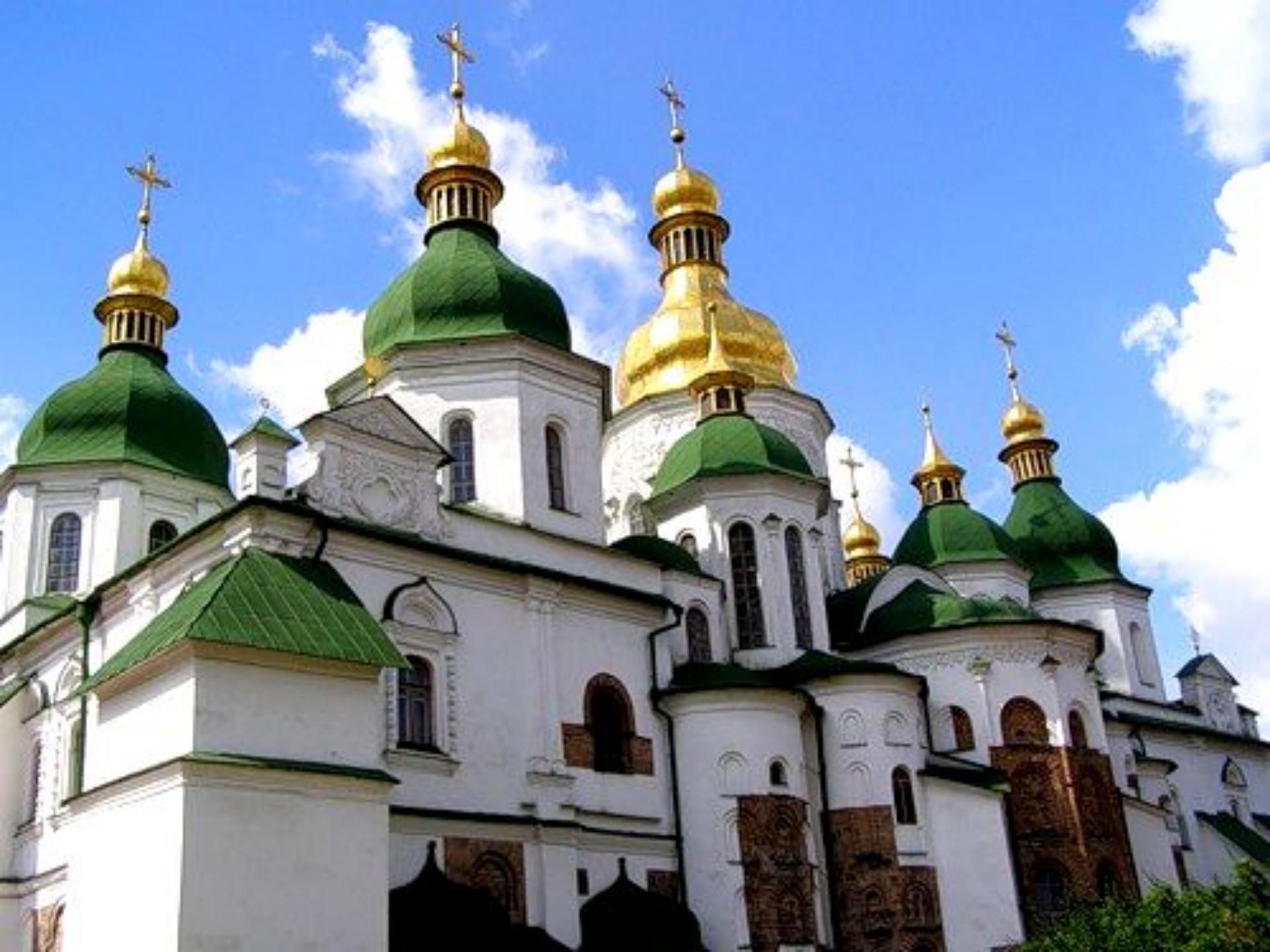
Софию первоначально венчали тринадцать глав, образующих пирамидальную конструкцию. Ныне у храма 19 глав. В древности кровля состояла из уложенных на своды свинцовых листов. По углам храм укреплен контрфорсами - вертикальными опорами с внешней стороны стены, которые принимают на себя ее вес. Для фасадов собора характерно обилие лопаток, которые соответствуют внутреннему членению пространства опорными столбами. Наружные стены галерей и апсид украшены многочисленными нишами.
