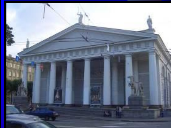
Манеж Конногвардейского полка (Арх. Д. Кваренги)
