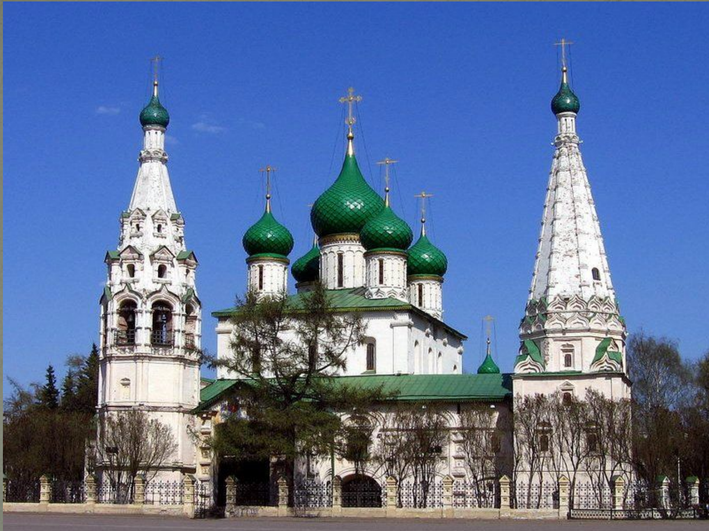
Церковь Ильи Пророка в Ярославле
