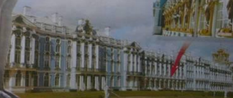
Пожарная опасность Екатерининского Дворца
