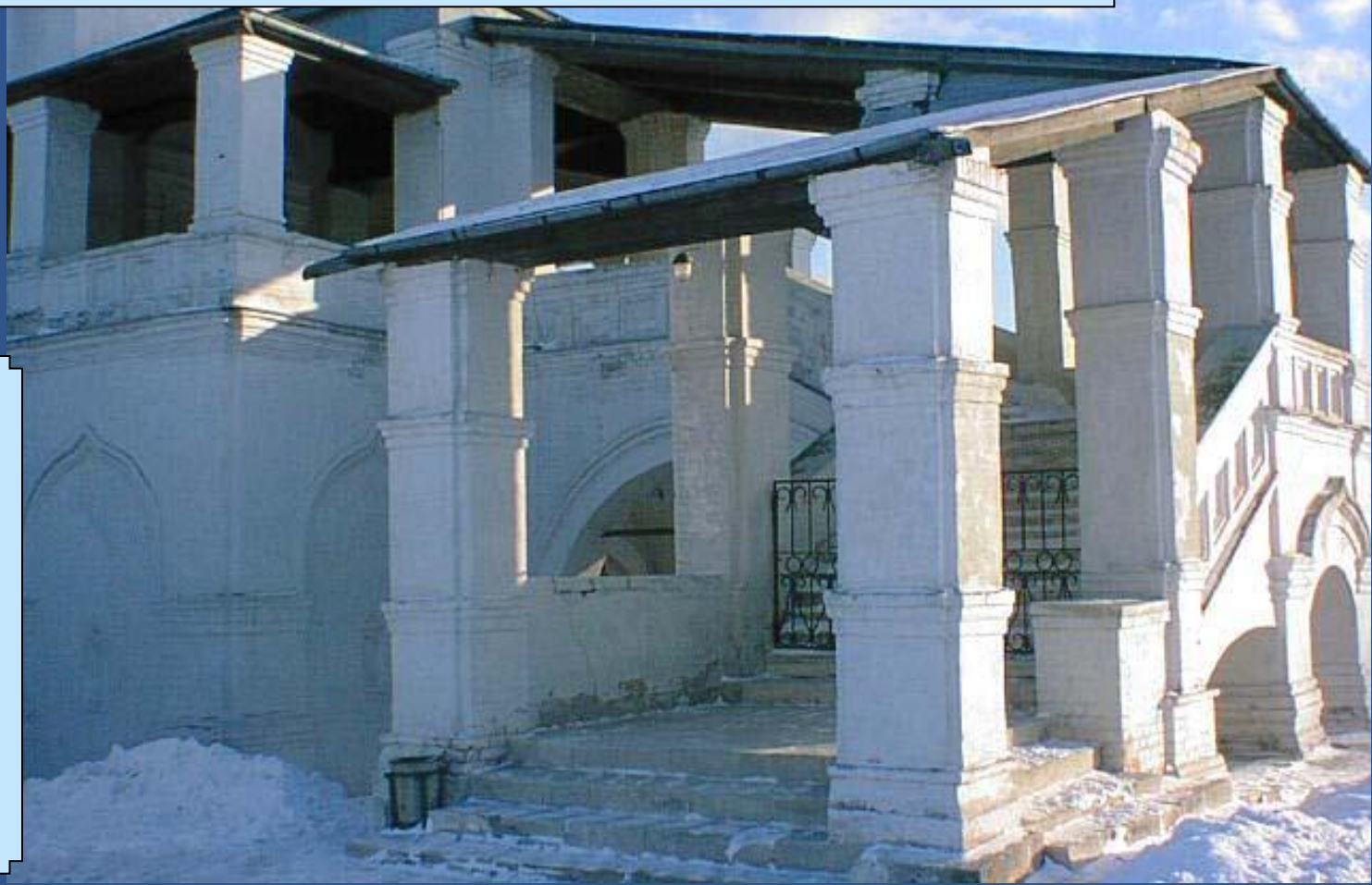
Церковь Вознесения в селе Коломенском под Москвой, вход на галерею, 1533
