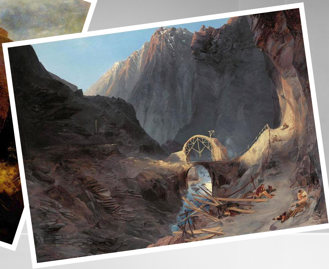
Постройка Чёртова моста, 1830-32
