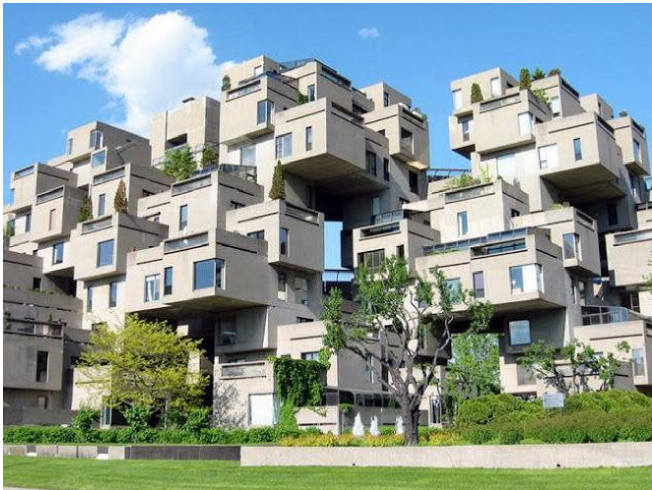
Жилой комплекс Habitat-67. Монреаль, Канада
