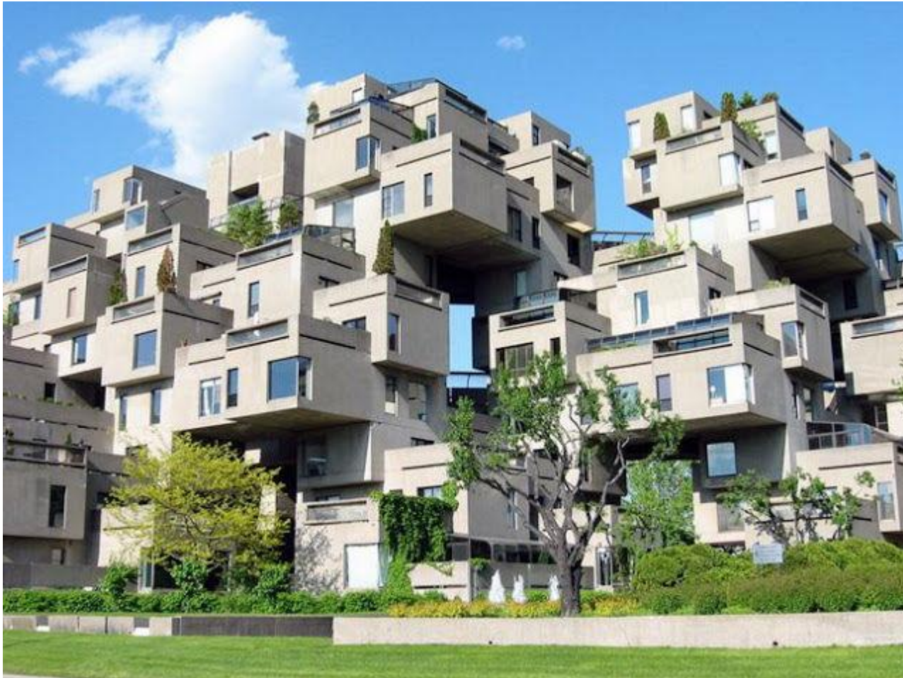
Жилой комплекс Habitat-67. Монреаль, Канада
