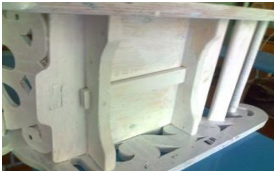
Резьбовые крепления опорных брусков под спинку.
