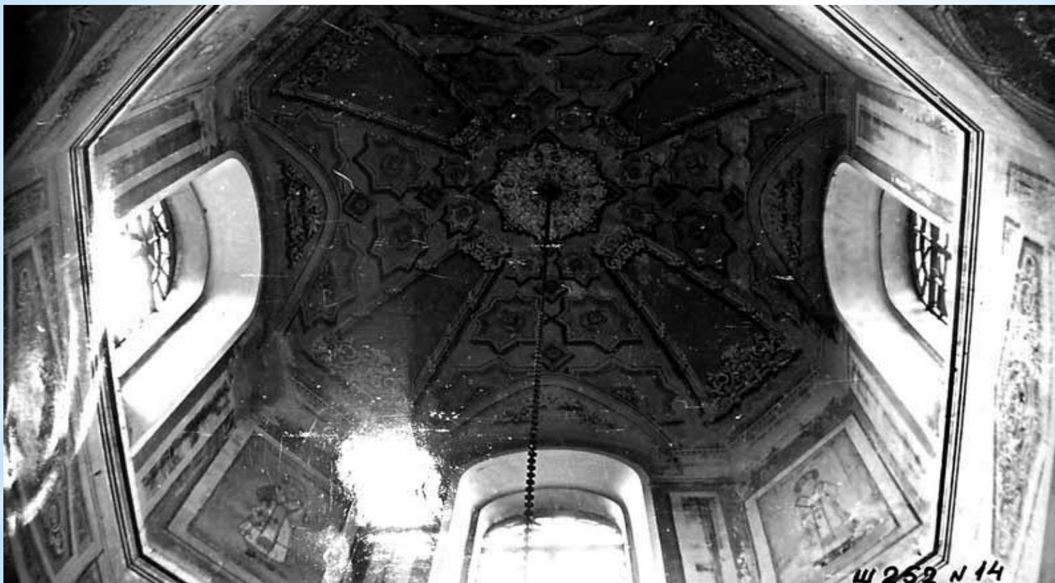
Внутри храм наполнен светом. Освещенность интерьера усиливается за счет особого устройства окон: снаружи, по углам четверика, они расположены на соседних гранях, а внутри два окна сходятся в одно, занимающее весь угол. Умелое расположение окон создает разнообразную игру света — от ослепительно-яркого до сильно затененного. По площади храм невелик — 8,5х8,5 метра, но при сравнительно небольшом пространстве в нем сохраняется ощущение простора.
