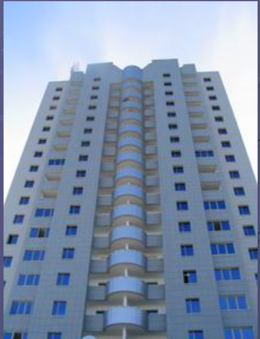
«Олимпийский» бизнес-центр, вид снизу-вверх
