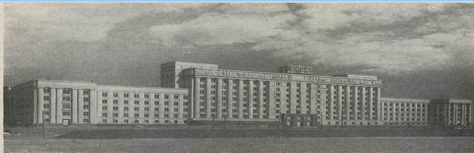
Дом Советов на Московском шоссе. Автор — член-корреспондент Академии архитектуры СССР Н. А. Троцкий. Строительство 1936—1941 гг.
