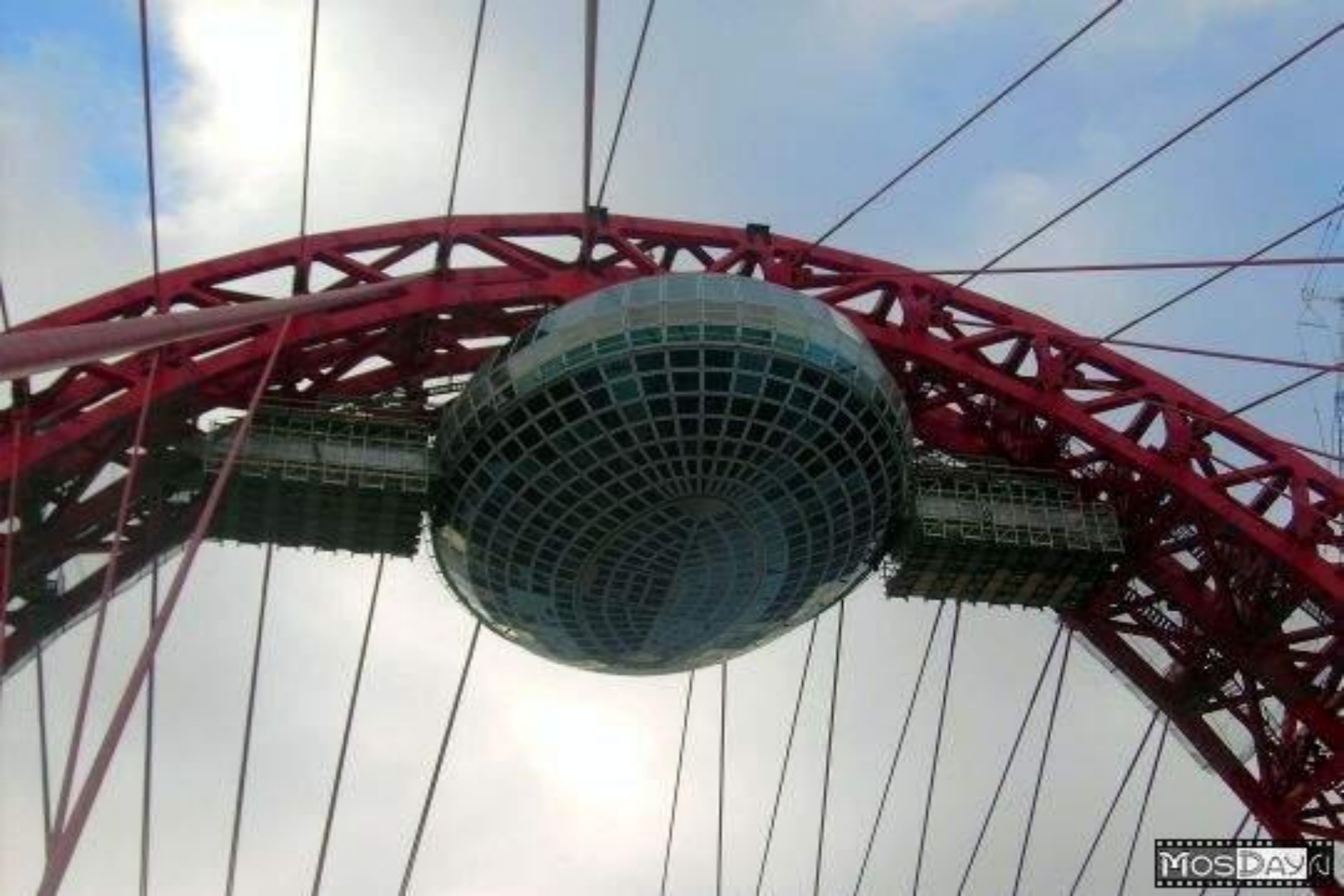
Пилон “Живописного моста” крупным планом вместе со строящимся рестораном и смотровой площадкой.
