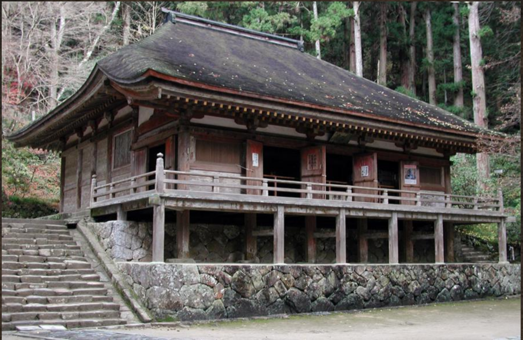
Храмовый комплекс Муродзи. Осн. в VII в., перестроен в IX в.
