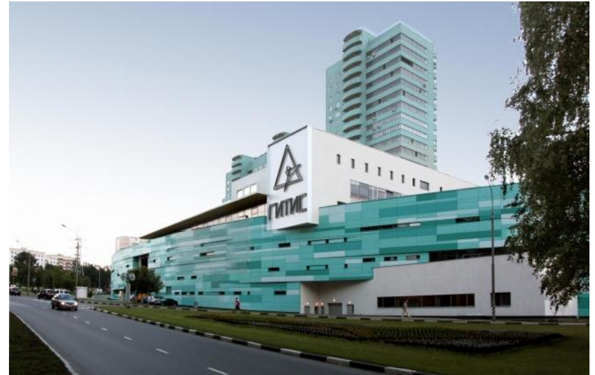
Новое здание ГИТИСа
