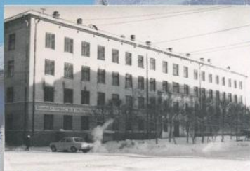
В 1961 году техникум переехал в новое здание
