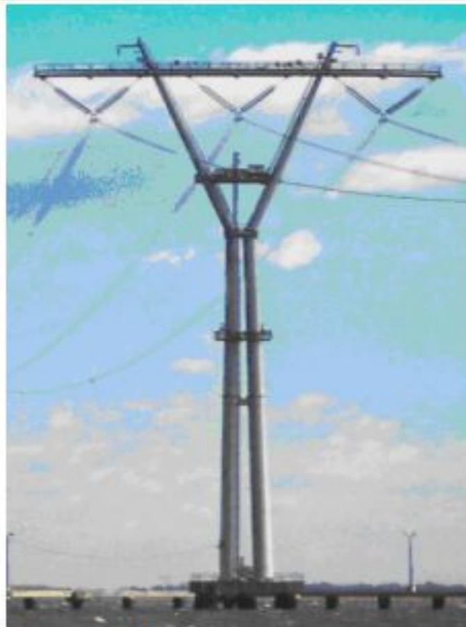
Рис. А.13 - Промежуточная опора большого перехода ВЛ 500 кВ
