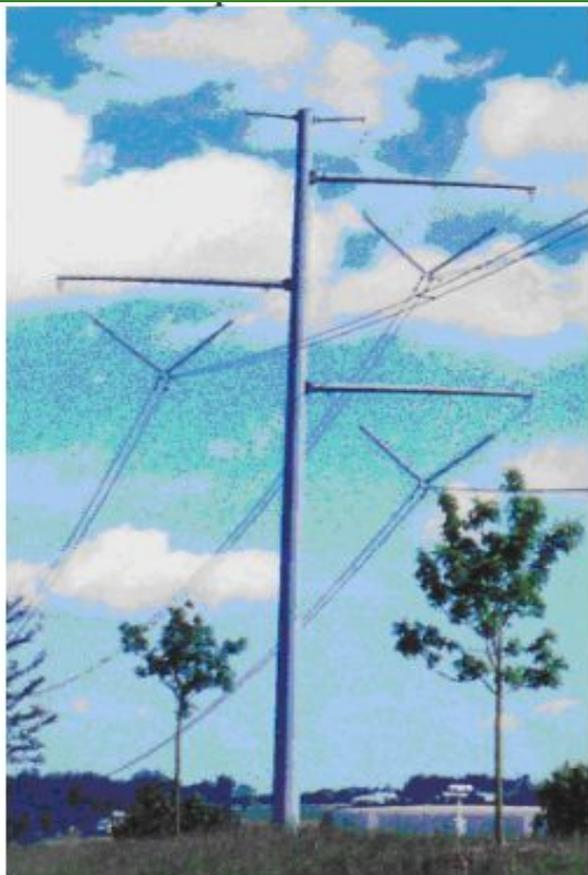
Рис. А.9- Одноцепная опора с V-образной гирляндой изоляторов.
