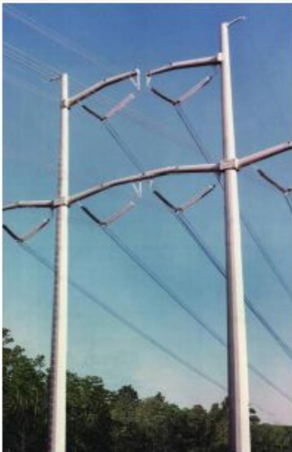
Рис. А.12 - Промежуточная двухстоечная опора
