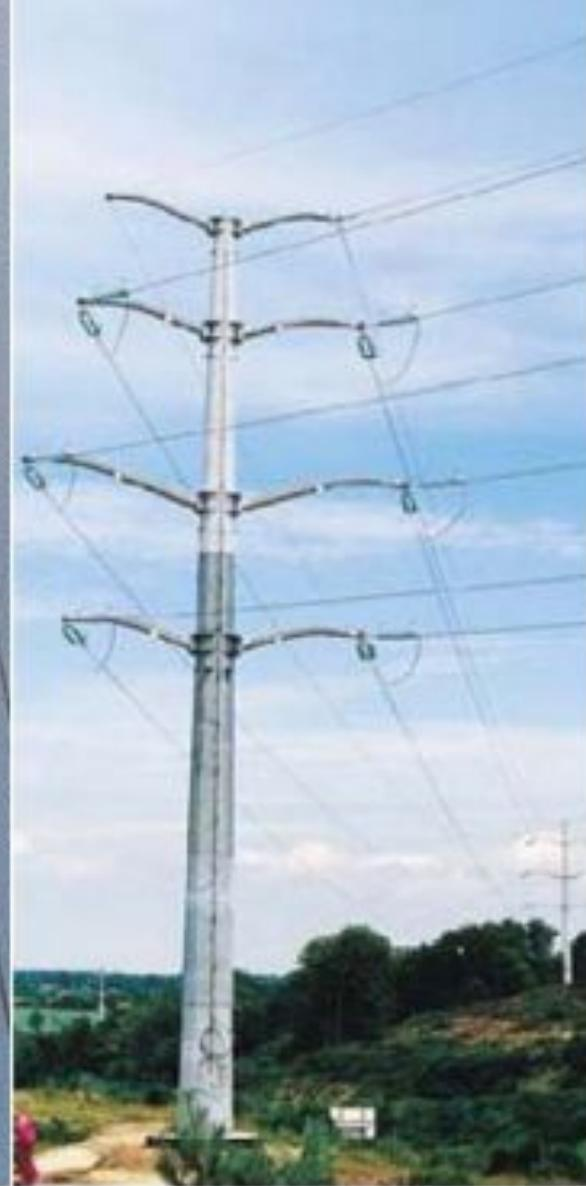
Рис. А.1 - Опора для перехода ВЛ в кабельную линию
