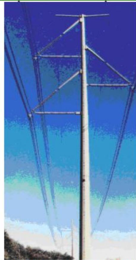
Рис. А.11- Промежуточная опора с изолирующими поворотными траверсами.
