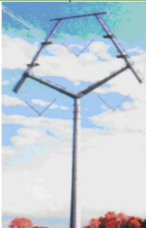
Рис. А.10- Промежуточная опора с проводами фаз, расположенными по треугольнику вершиной вверх.
