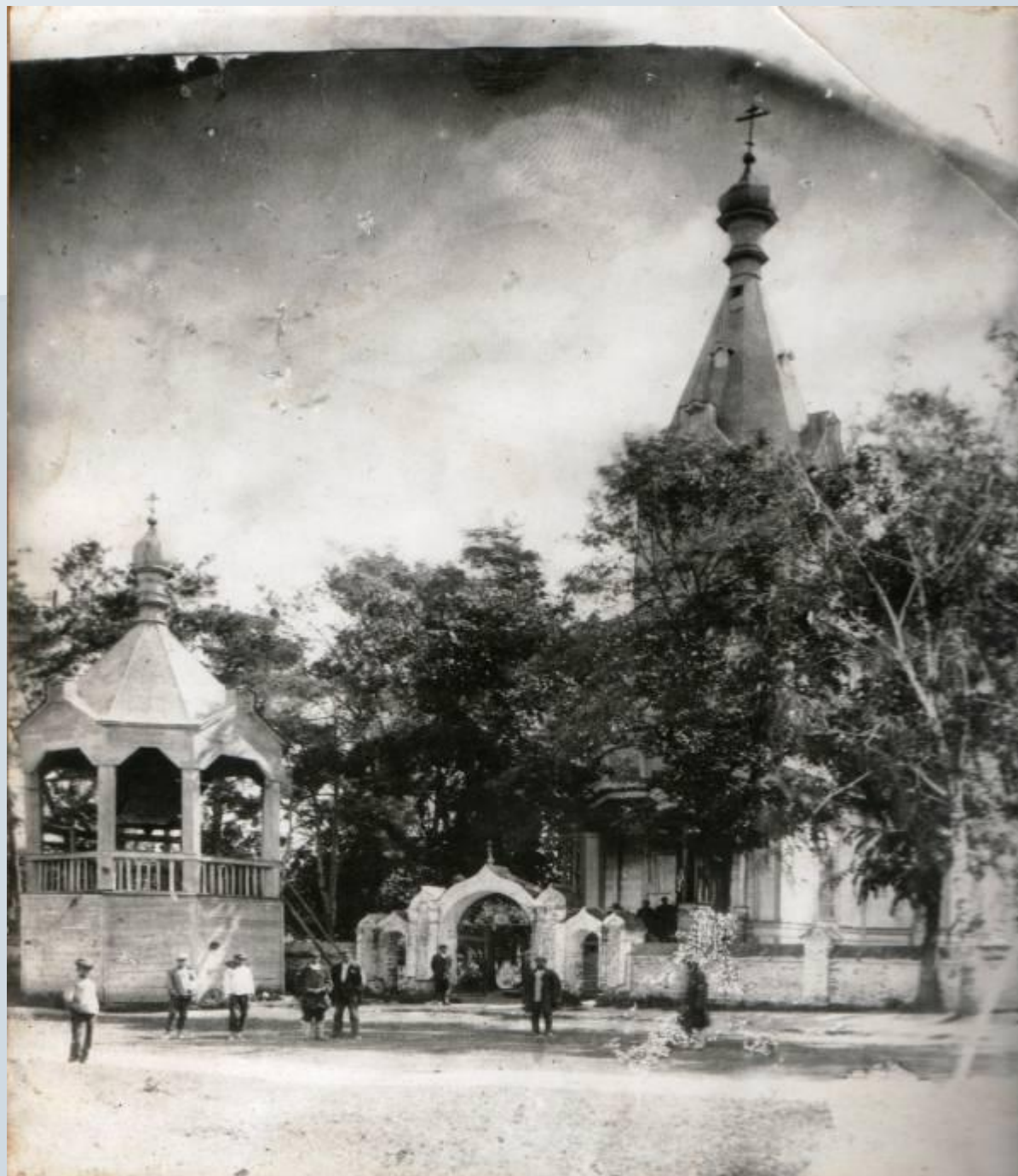
Фото разрушенного храма
