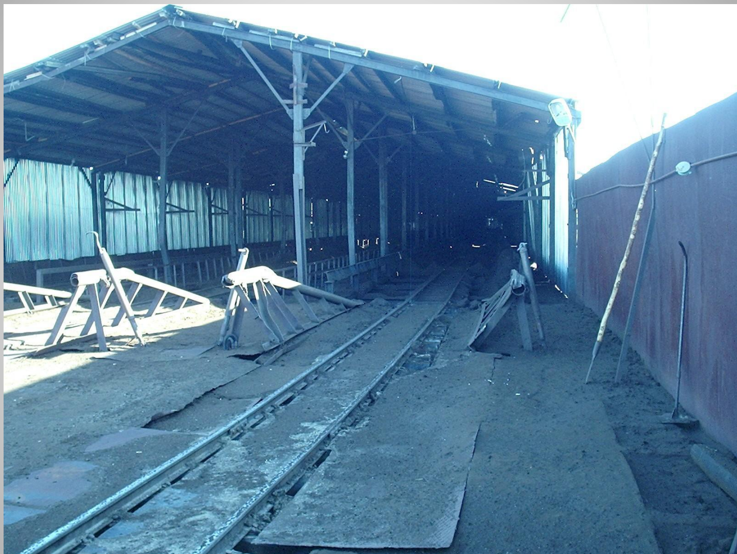
Верхняя разгрузочная часть торфоперегрузочной эстакады.
