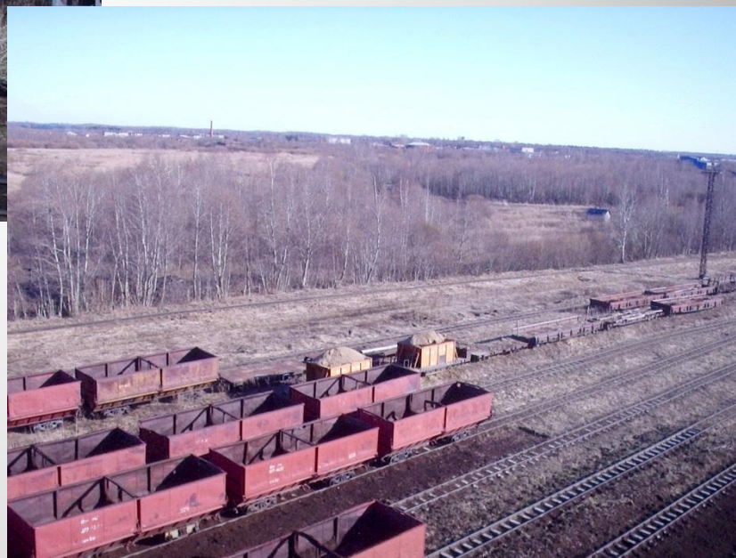
Станция Перегрузочная в 2004- 2007 г.г.
