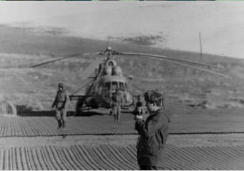
Вертолетная площадка из сборных металлоконструкций (4 комендатура «Хумлы»)
